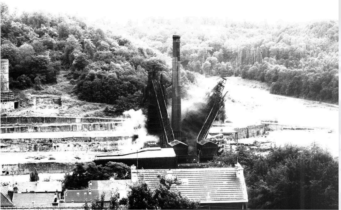
Dynamitage des hauts fourneaux 4 et 5 de Senelle - juillet 1991 / Crédit photo : Sylvain Dessi
