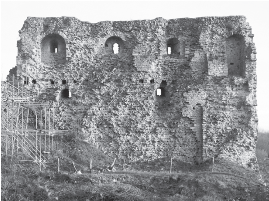
Fig. 11 : Donjon de Vaudémont, mur sud-est. Le parement intérieur arraché, permet d'observer la disposition en épi du blocage. Photo C. Moulis.
