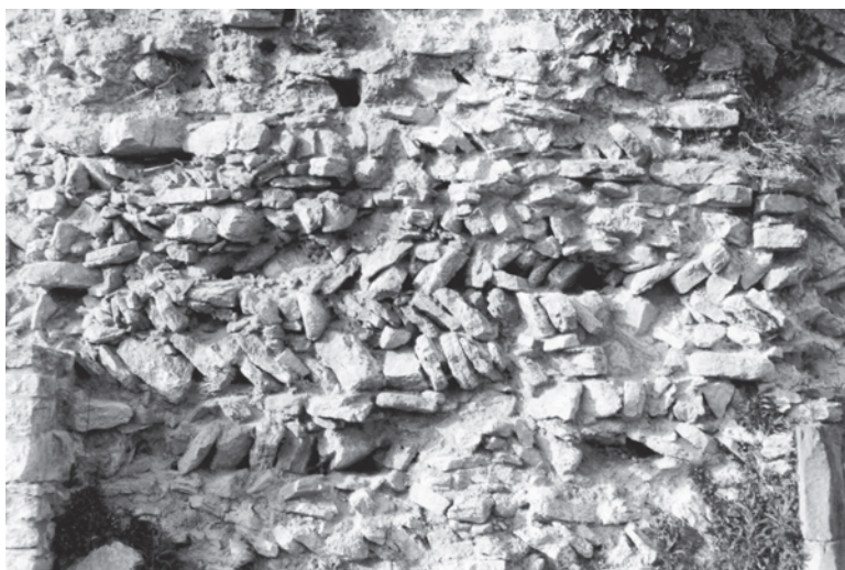
Fig. 8 : Château de Blâmont, courtine nord. Blocage en épi. Photo C. Moulis.
