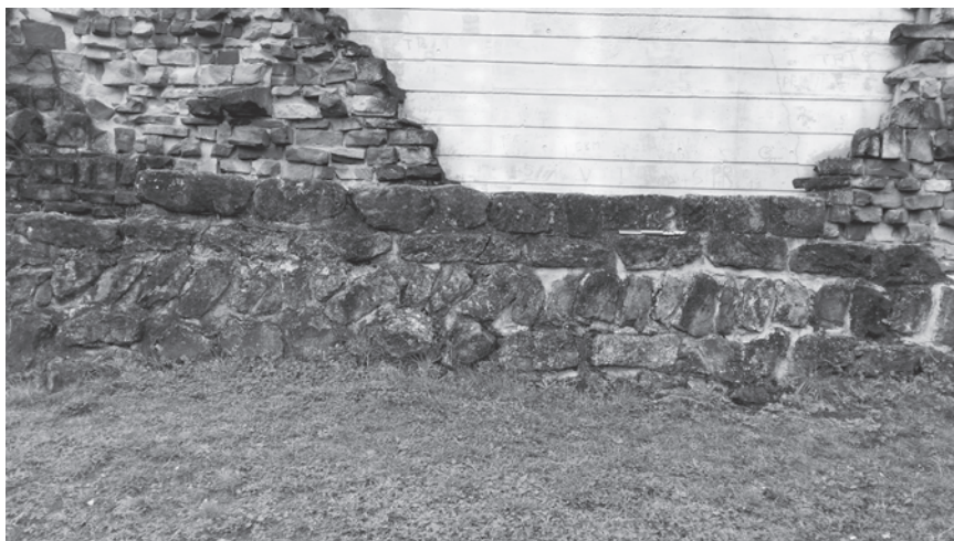
Fig. 4 : Château d'Épinal. Vestige de maçonnerie en épi à l'intérieur du donjon. Photo C. Moulis.
