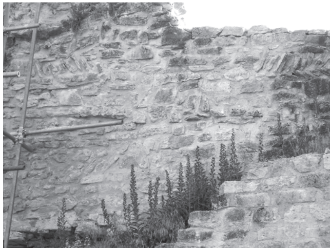
Fig. 6 : Château de Blâmont, courtine est. Rangs d'épis partiels en parement. Photo V. Muller.
