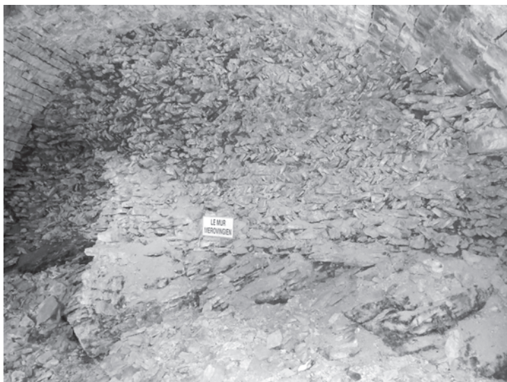
Fig. 12 : Château d'Arlay. Blocage en épi qui rappelle celui observé à Vaudémont. Photo C. Moulis.
