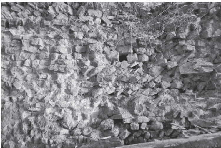
Fig. 7 : Tour seigneuriale de Darnieulles. Blocage du mur est. Photo C. Moulis.
