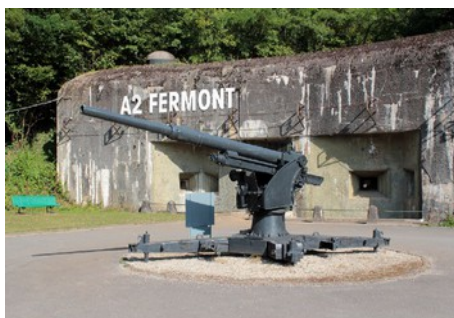
Le fort de Fermont
