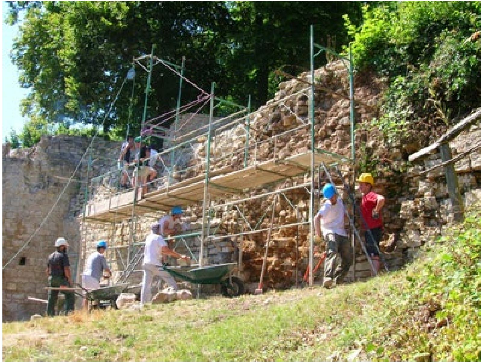
Chantier bénévole en Grand Est
